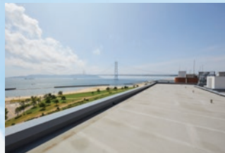
メノン舞子シアター（神戸市垂水区） ニューブレん機械固定/高反射塗料
