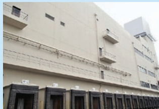
商業施設（大阪府茨木市）配送センター 外壁改修工事
