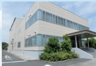
倉庫（大阪府茨木市）物流倉庫 外壁改修工事
