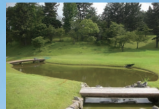
ゴルフ場（大阪府茨木市） 遮水工事
