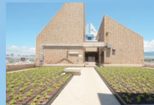
消費生活総合センター（神戸市） 屋上防水改修工事および緑化工事
