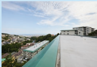
シャルマンコーポ御影（神戸市東灘区） ニューブレん断熱機械固定/高反射塗料
