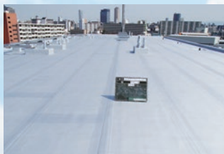
大阪市営住宅（大阪市） 屋上防水改修工事 ゴムシート/断熱仕様
