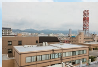
三ツ星ベルト(株)本社（神戸市長田区） 屋上防水改修工事 ゴムシート/断熱仕様
