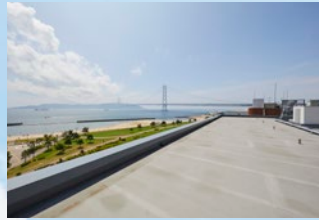
メノン舞子シアター(神戸市垂水区) ニューブレイン機械固定/高反射塗料
