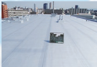
大阪市営住宅(大阪市) 屋上防水改修工事 ゴムシート/断熱仕様
