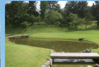
ゴルフ場(大阪府茨木市) 遮水工事
