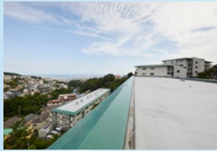
シャルマンコーポ御影(神戸市東灘区) ニューブレイン断熱機械固定/高反射塗料
