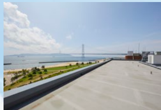
メノン舞子シアター(神戸市垂水区) ニューブレンド機械固定/高反射塗料
