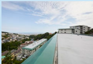
シャルマンコーポ御影(神戸市東灘区) ニューブレンド断熱機械固定/高反射塗料
